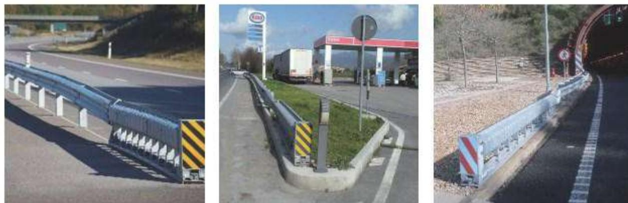
Fig. 6 – esempio di installazione di Terminali
