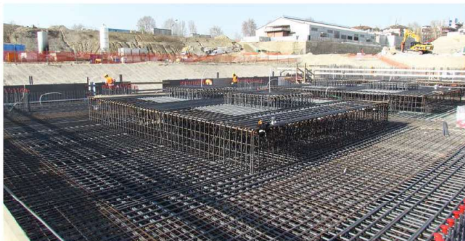
Visita cantiere TCa
