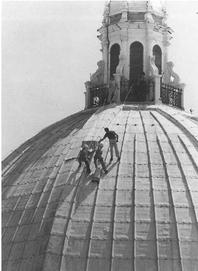
*Pronto intervento per la sostituzione localizzata di lastre in piombo*
