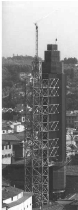
TRALICCIO INTERNO E TORRE AUSILIARIA PER IL SOSTEGNO DEI PONTEGGI
