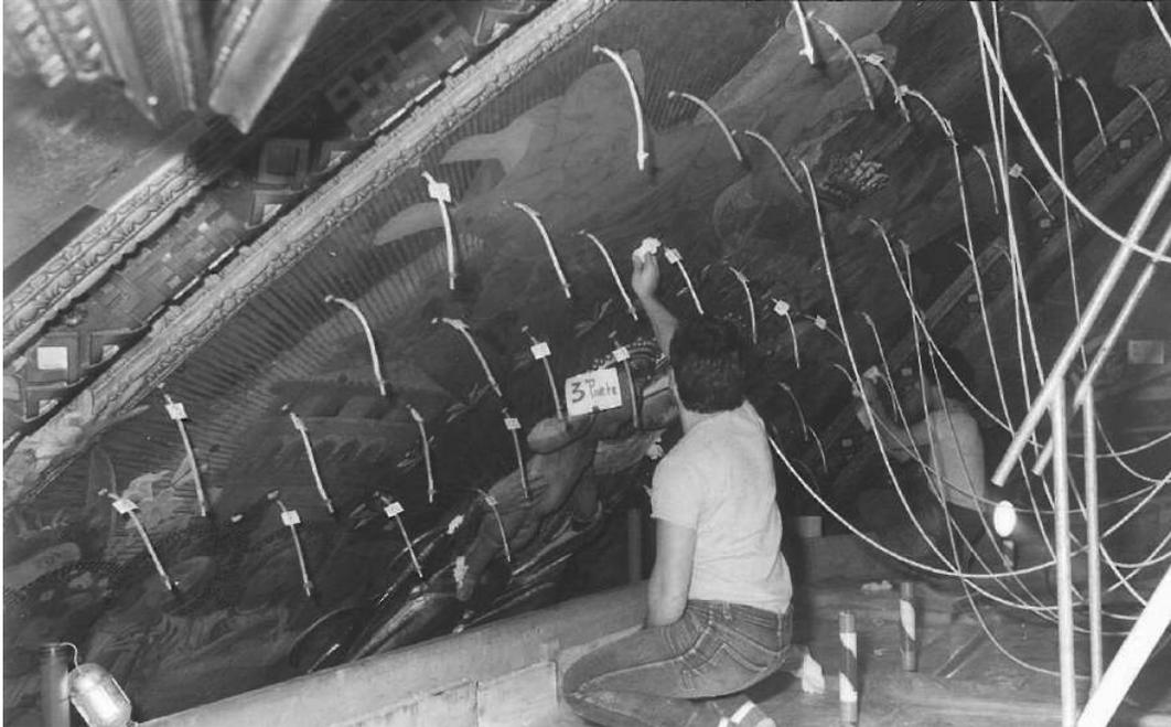
*Consolidamento degli intonaci affrescati mediante iniezioni per la riadesione al supporto*
