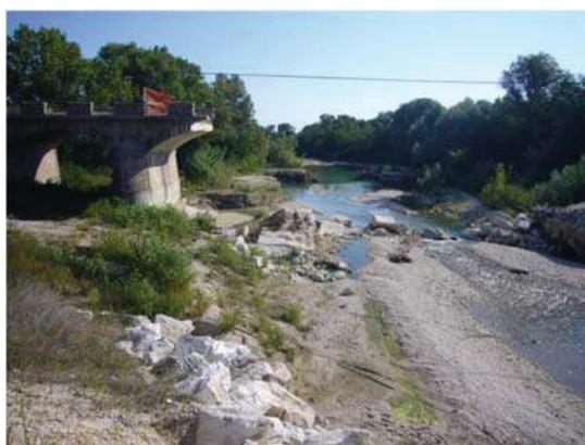
ponte provvisorio realizzato a monte del ponte crollato – vista delle due sponde del ponte crollato
