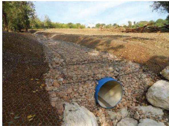
Sistemazione del fosso in via Paradiso con rinforzo corticale sulle sponde mediante geocomposito formato da rete metallica preaccoppiata ad una biorete in cocco
