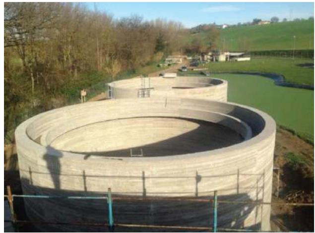
Costruzione delle vasche dell'impianto provvisorio (poi destinate alla linea fanghi nell'impianto definitivo)
