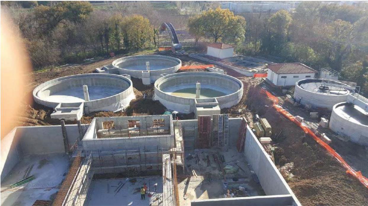
Le vasche per le tre linee della sezione biologica - le tre vasche circolari di sedimentazione - l'attraversamento del Nevola con i collettori - la stazione di filtrazione con il manufatto per la disinfezione - l'impianto provvisorio in funzione
