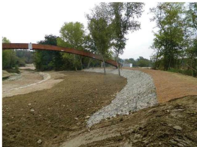
Ricostruzione dell'alveo di piena e protezione con massi 2<sup>a</sup> categoria sull'alveo di magra
