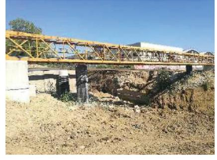
Demolizione del ponte esistente e traliccio provvisorio per le reti Enel, Telecom, acqua, metano
