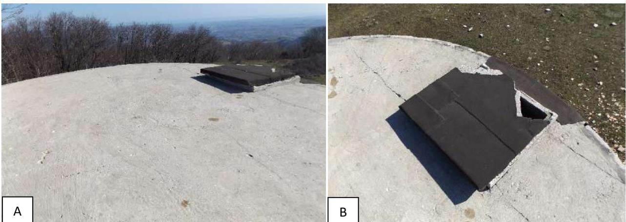
*Fig.7 Particolari del coperchio del serbatoio. A mancanza di guaina impermeabilizzante, B rottura del coperchio in cemento.*
