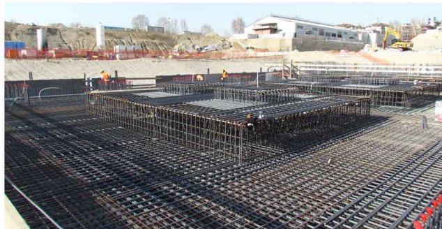
Visita cantiere TCa
